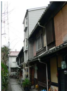
写真3 セットバックせずに改修した3階建て
